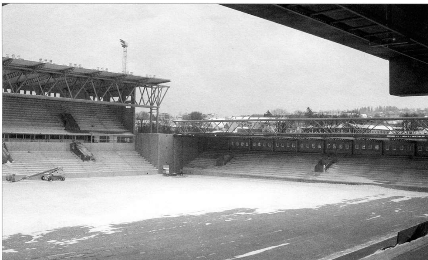
Borås Arena 2005-02-14. Bilden är tagen från södra läktaren mot nordöstra hörnet.
